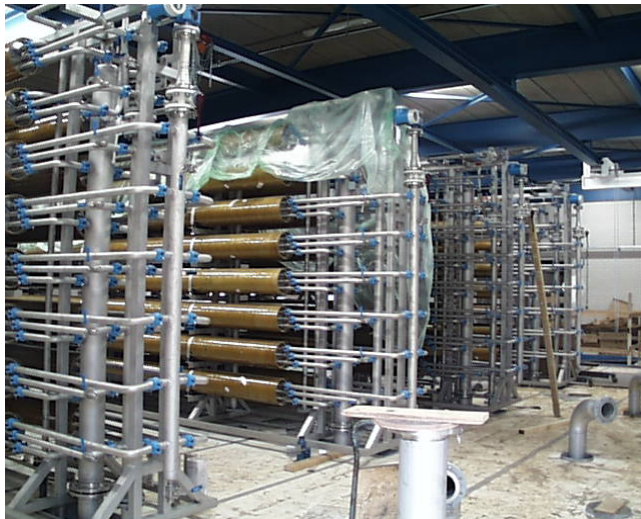
Figur 6. Nanofiltrerings anlægget (OPTIFLUX) på Engelse (Vitens-Overissjel, Holland) under opførelse.
